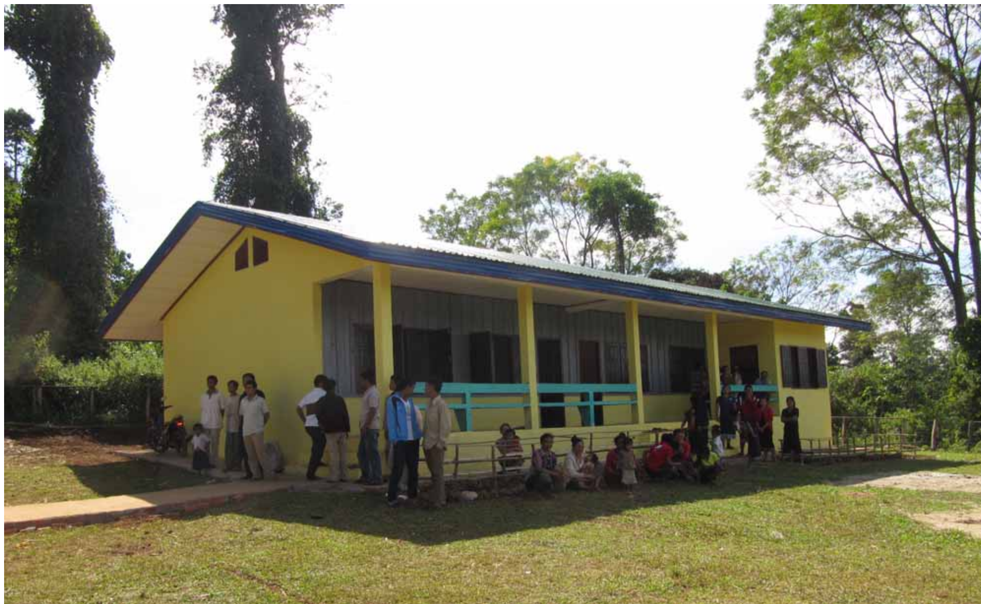
隣の校舎との間を渡り廊下でつなぎ、雨季でも足が汚れないよう工夫されています
